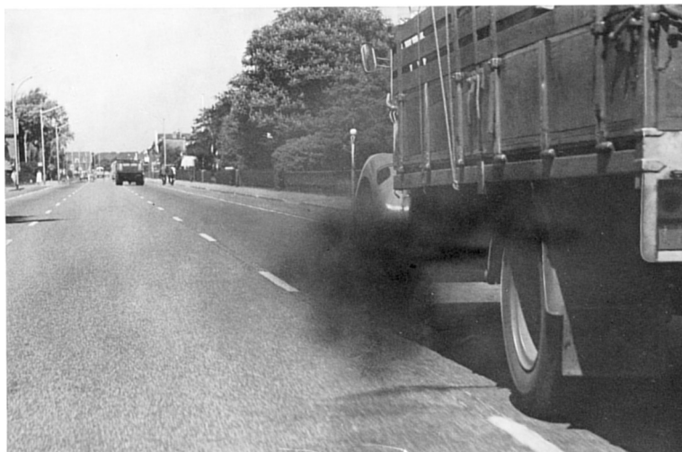
Afbeelding 1.3 In het verleden was stofvormige luchtverontreiniging vaak en veel in het dagelijks leven waar te nemen, zoals hier bij een vrachtwagen in de jaren zestig. Foto collectie E. Buijsman.
